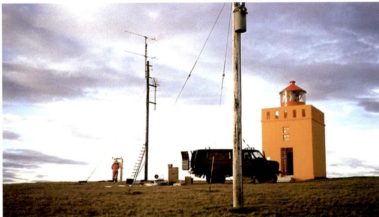
Hér er verið að setja upp sjálfvirka veðurathugunarstöð á Rauðanúpi (ljósm.: Elvar Ástráðsson).
