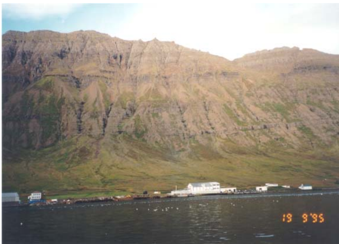
Mynd 4. Bræðslugjárnar 3 eru vinstra megin við miðja mynd, en Miðstrandarskarð til hægri. Snjóflóð úr þeim fóru í sjó fram, Bræðsluflóðið og Mánaflóðið, 20.12.1974. Alls létust 12 manns.
