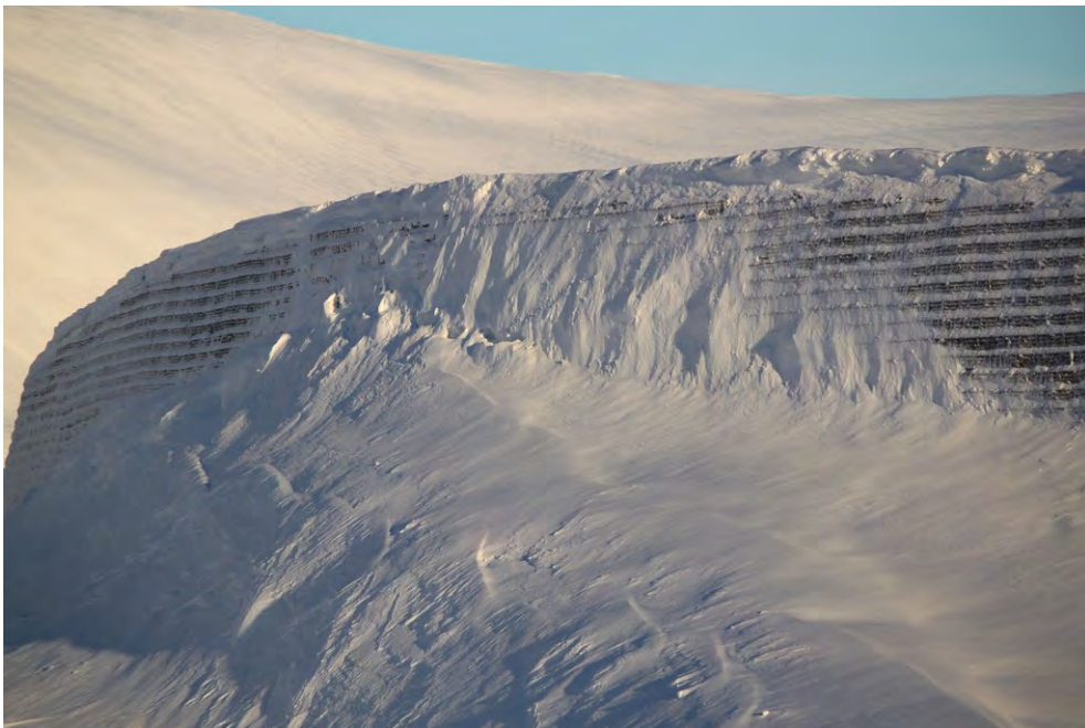
Mynd 10. Varnargarðurinn í Bjólfinum og ummerki flóðsins sem kastaðist yfir garðinn á um 70 metra kafla
