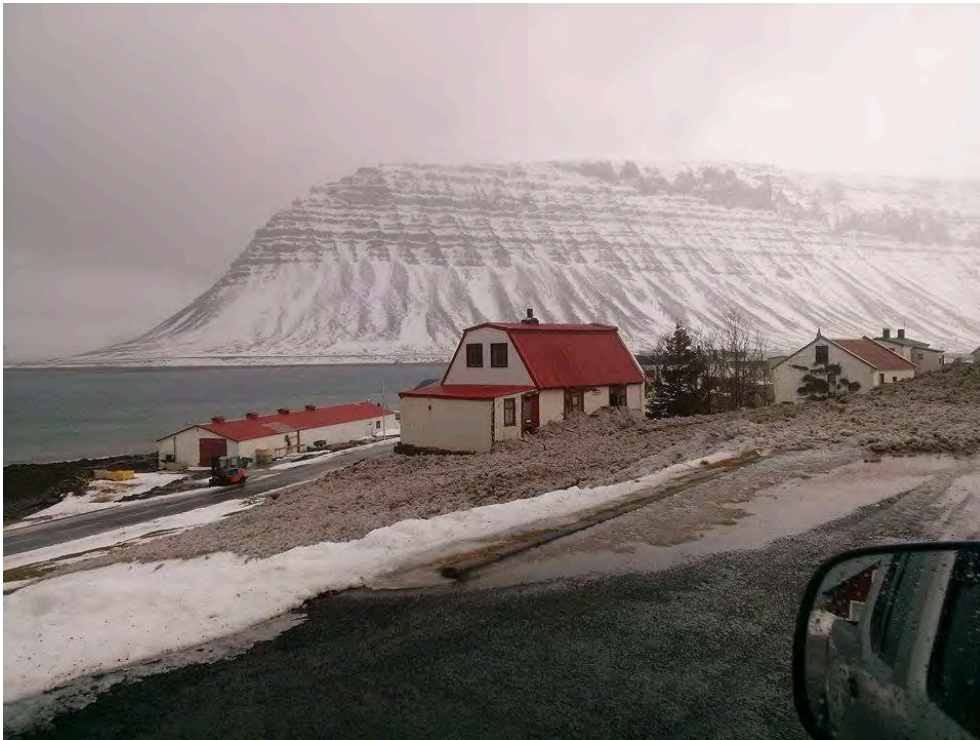
Mynd 21. Krapaflóðið í Búðargili fór yfir Lönguhlíð og á húsið Höfðabrún. Engin búseta er í húsinu sem er óvarið fyrir flóðum úr Búðargili.
